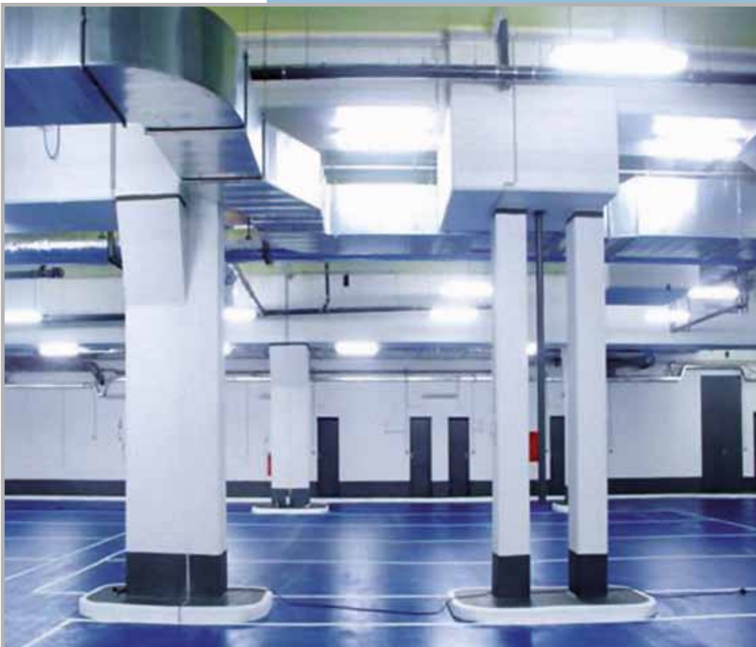
Репрофилиране на повърхността, предназначена за пешеходно и автомобилно движение, на паркинга в търговския център, с използването на смесите за запълване на повредени места TS 630 и TS 635 на фирма Кнауф.
