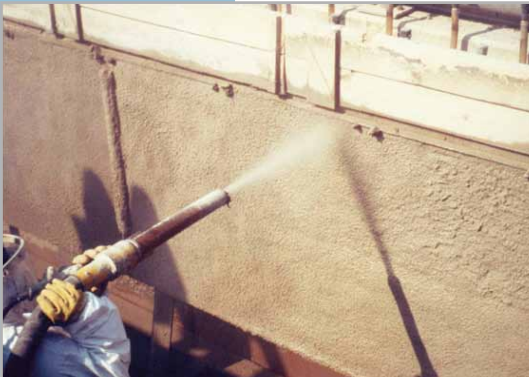
Пример за покриване чрез впръскване на бетон по мокър метод
