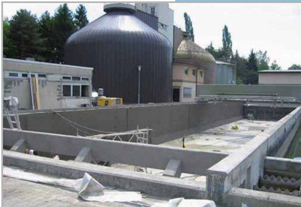
Репрофилиране на кожата на утаителния резервоар на съоръжението за пречистване на отпадни води.
