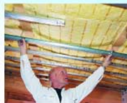
Окачване на Кнауф CD профилите към анкерните окачвачи
