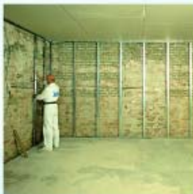
Монтаж на металната конструкция за Кнауф предстенна обшивка
