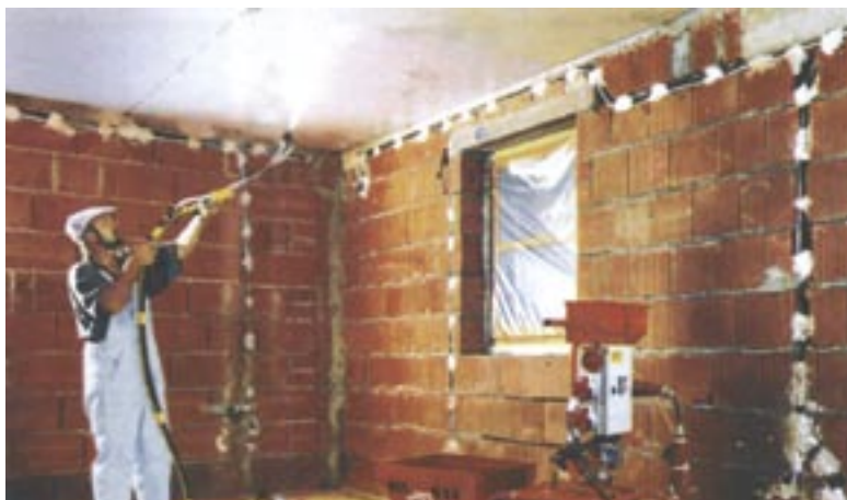
При големи обекти се препоръчва машинно нанасяне на материалите
